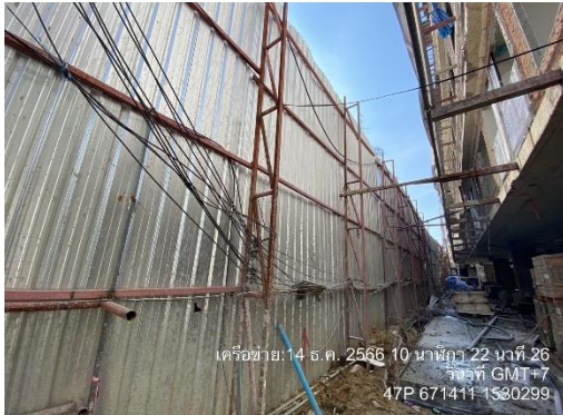
รูปที่ 1 ติดตั้งรั้ว Metal Sheet รอบพื้นที่ก่อสร้าง (ปัจจุบันทำการรื้อออกเรียบร้อยแล้ว)
