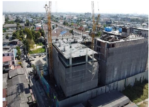
รูปที่ 41 ผ้าใบก่อสร้าง Mesh sheet (ปัจจุบันทำการรื้อออกเรียบร้อยแล้ว)
