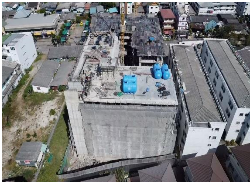
รูปที่ 41 ผ้าใบก่อสร้าง Mesh sheet (ปัจจุบันทำการรื้อออกเรียบร้อยแล้ว)
