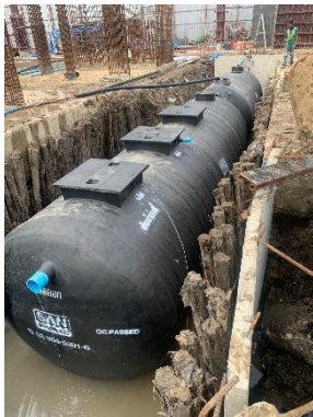
รูปที่ 31 ระบบบำบัดน้ำเสียสำเร็จรูป
